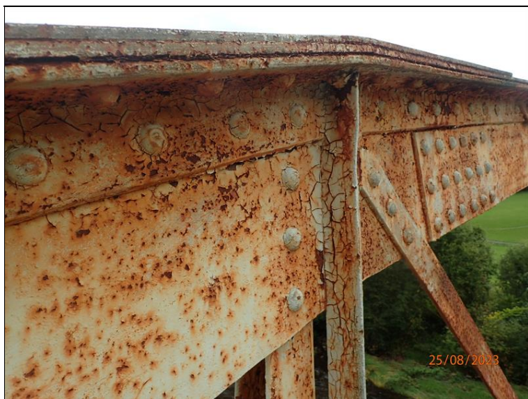
Aktuální stav protikorozi ochrany horního pasu L oblouku.
