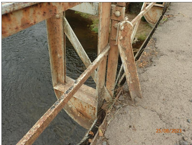
Spodní část svislice polorámu, římsový plech, profil protinárazové ochrany.
