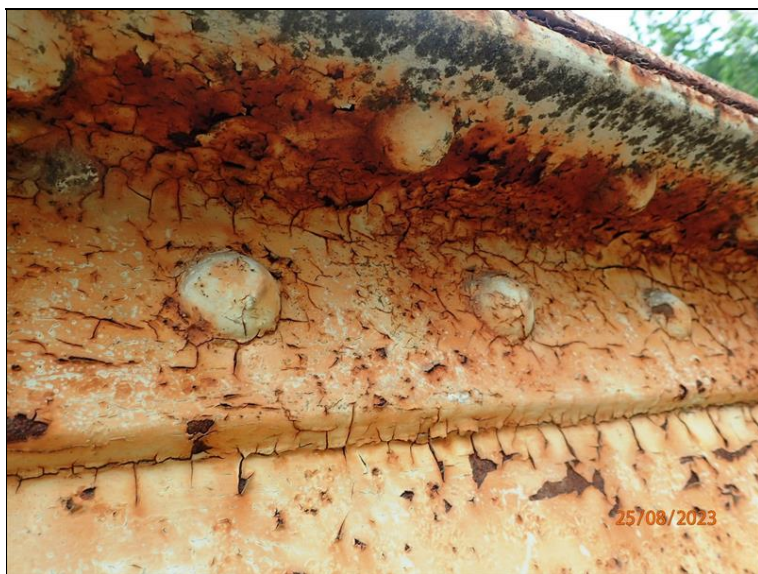
Detail aktuálního stavu protikorozní ochrany horního pasu P oblouku.
