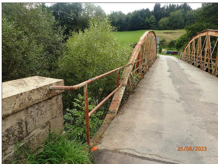
Opěra O1, L krajnice, zábradlí, parapetní zeď.
