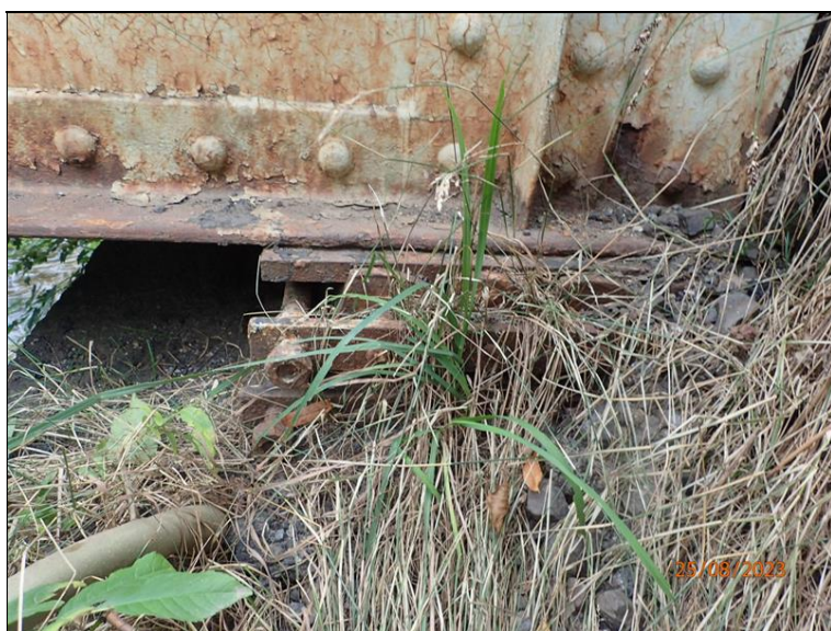
Opěra O1, L válcové ložisko.
