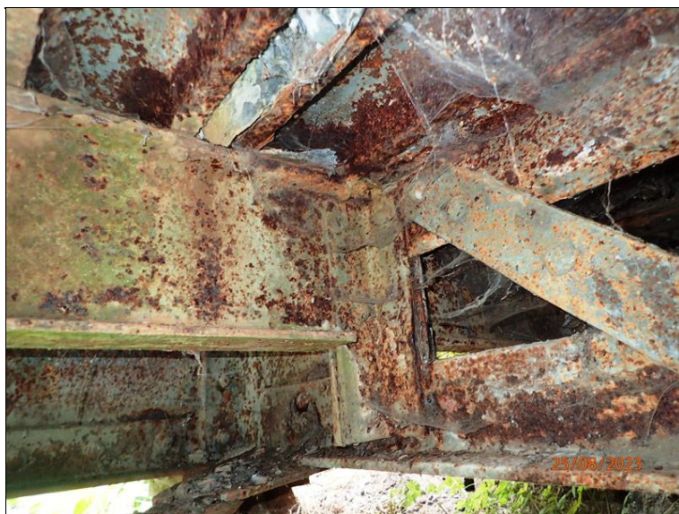
Opěra O2, aktuální stav podélníku a příhradového příčníku.
