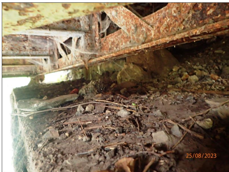
Pohled na úložný práh opěry O2, koncový příčník od P boku mostu.
