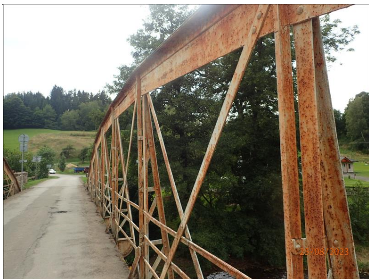
P obloukový pas, svislice příčných polorámů, subtilní svislé ztužení
