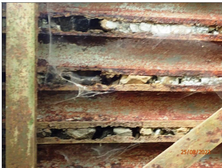
Opěra O2, podhled mostovky, mezery zkorodovaných profilů "Zóres", z nich vypadaná hrubá zrna kameniva.
