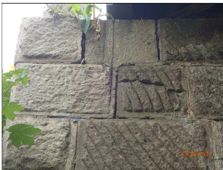
Líc dříku opěry O2, lomená trhlinka u jeho L nároží.
