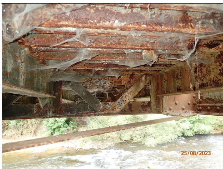
Opěra O2, aktuální stav mostovky mezi krajními L podélníky.
