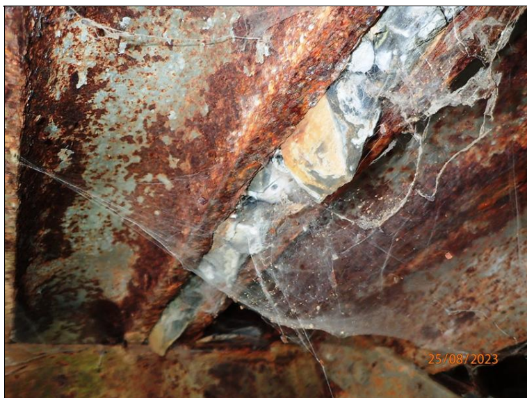
Opěra O2, podhled mostovky, mezera 2 profilů "Zorés", v ní zaklíněná hrubá zrna kameniva.
