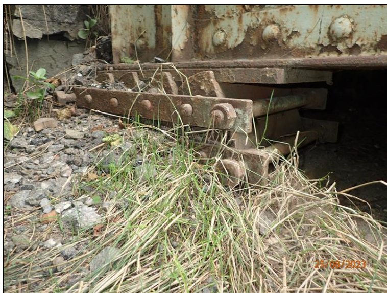
Opěra O1, P válcové ložisko.
