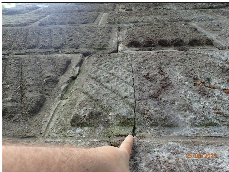
Líc dřívku opěry O2, trhlina přetínající kvádr u jeho L nároží.
