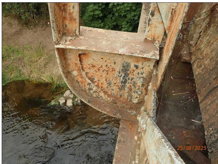
Detail rámového rohu mezi svislicí a příčnickem polorámu.
