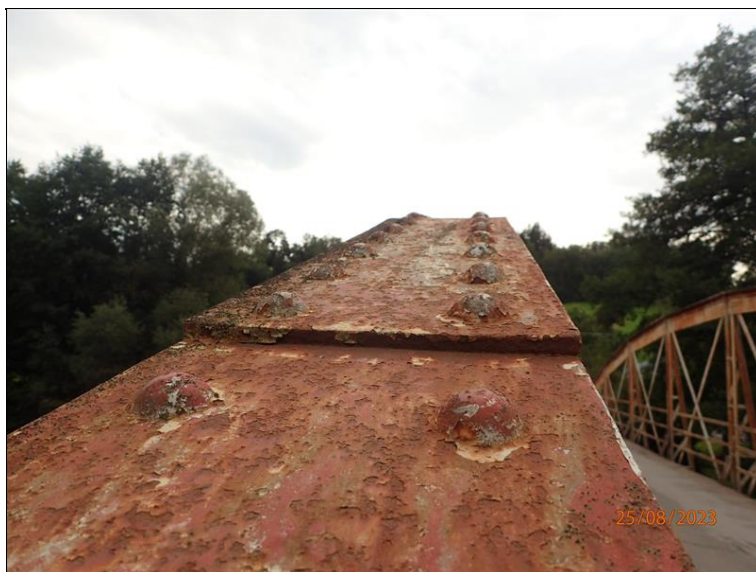
Aktuální stav na horním povrchu L obloukového pasu.
