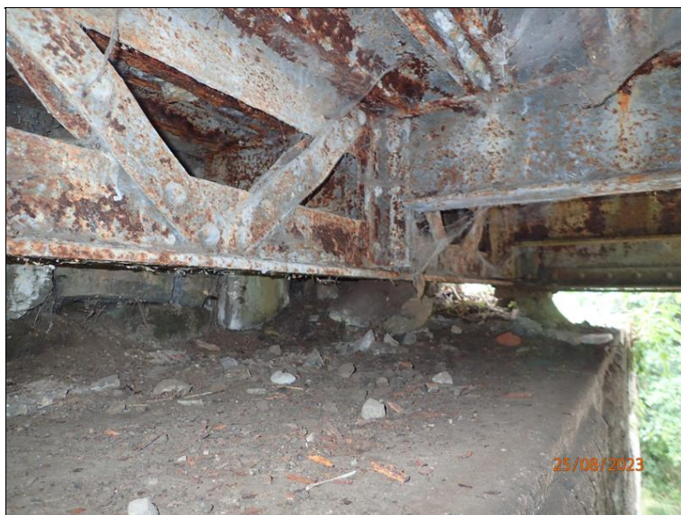
Pohled na úložný práh opěry O2, koncový příčník od L boku mostu.
