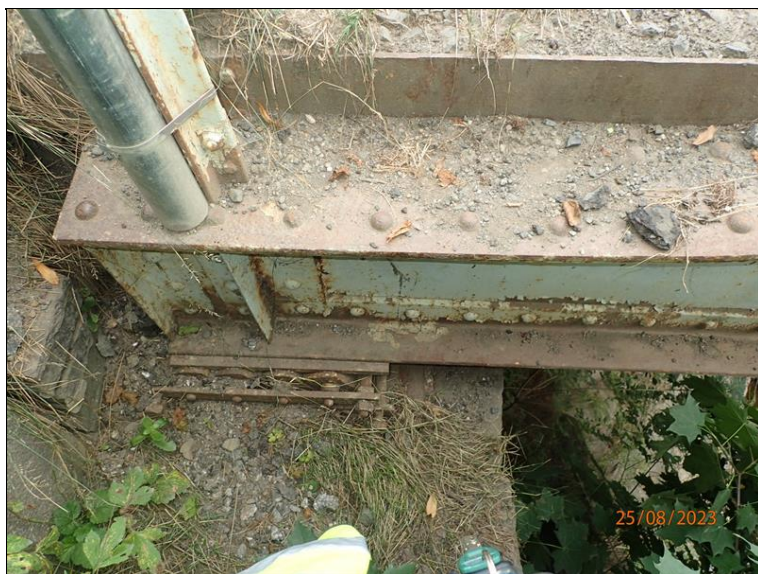
Opěra O1, aktuální stav uložení konce P oblouku na válcové ložisko.
