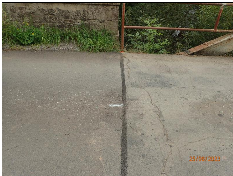
Opěra O1, konec NK, pohled v linii příčné dilatační spáry v krytu vozovky.
